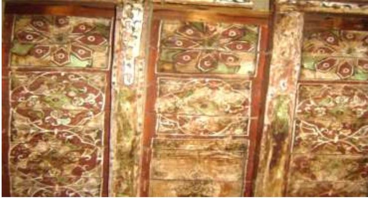
صورة رقم (٢٥) توضح انفصال أجزاء من طبقة التحضير واللون نتيجة لتفاوت معدل انكماش طبقة الرسم والحامل الخشبي بسبب تفاوت معدل درجات الحرارة والرطوبة
